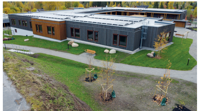
Plan to er utført med moduler fra Moelven. Bygget er kledd med Vær-bitt-kledning, også fra Moelven. Foto: Ådne Homleid
